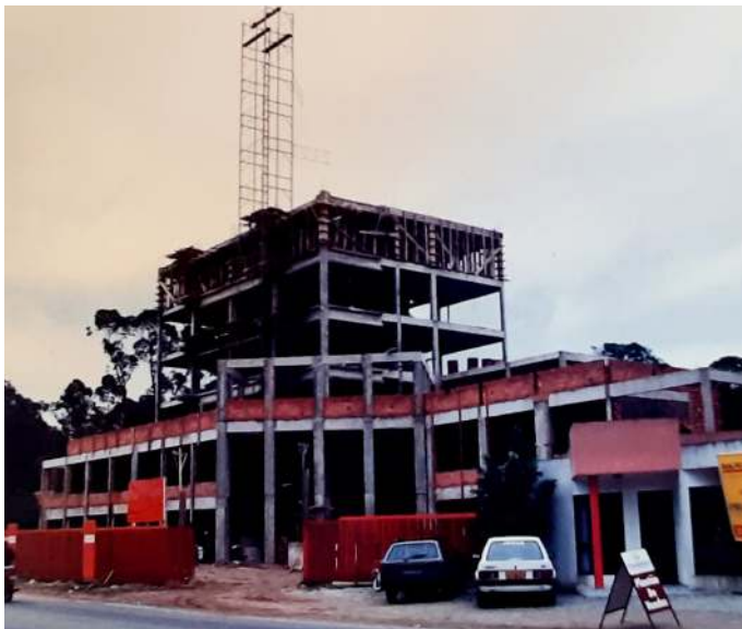
Construção do prédio no bairro Itacorubi
